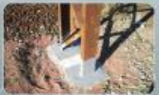
ПКП Защита опор от коррозии
