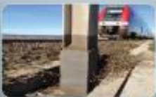
REINFORCEKIT BEAM Ремонт опор
