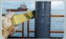
REINFORCEKIT 4D Ремонт опор морских платформ
