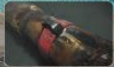
STOPKIT SUBSEA Устранение утечек под водой
