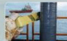
REINFORCEKIT 4D Ремонт опор морских платформ
