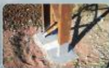
ПКП Защита опор от коррозии
