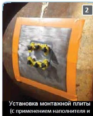
2 Установка монтажной плиты
