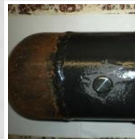
Испытания на прочность покрытия
