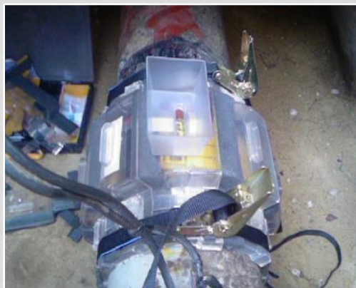
Гильза закреплена на СТОПКИТ Временный
