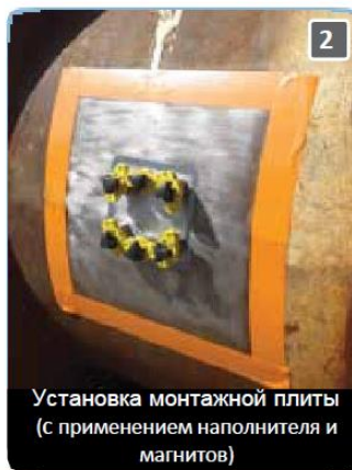
Оцинкованный лист 120x120 мм.с магнитами и наполнитель F3X8
