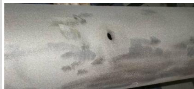
Ремонт сквозных отверстий : 200 бар
