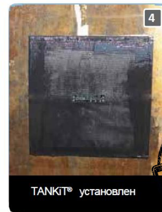
Накладка из кевлара – 5 слоев 300x300 мм. и смола R3X5
