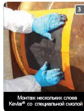
Накладка из кевлара – 5 слоев 300x300 мм. и смола R3X5
