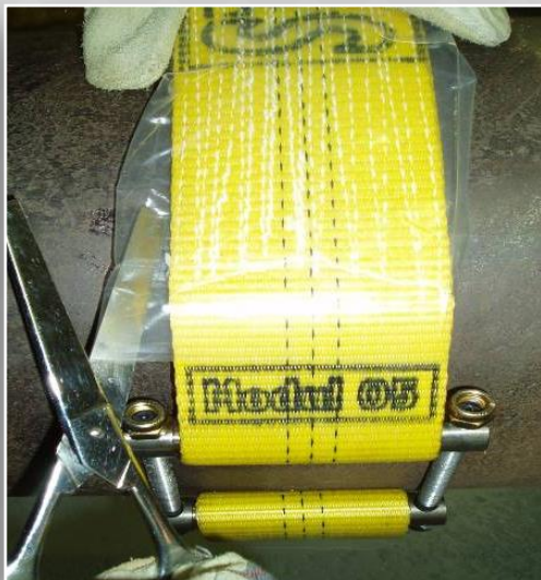
Удаляется полиэтиленовый чехол
