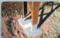
DKIT Защита опор от коррозии
