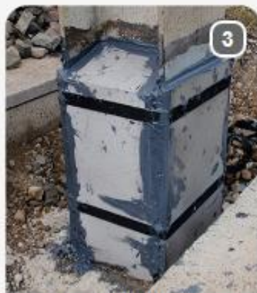
3 Установка металлических вкладышей
