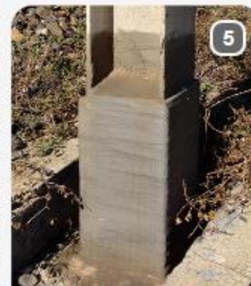
5 Защита от ударных воздействий и УФ
