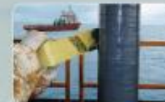
REINFORCEKIT 4D Ремонт опор морских платформ
