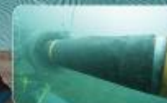
REINFORCEKIT 4D SUBSEA Композитный ремонт подводных трубопроводов
