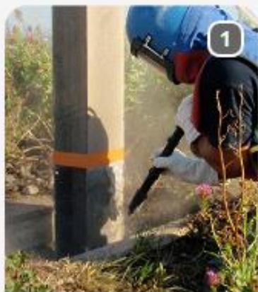
1 Подготовка поверхности
